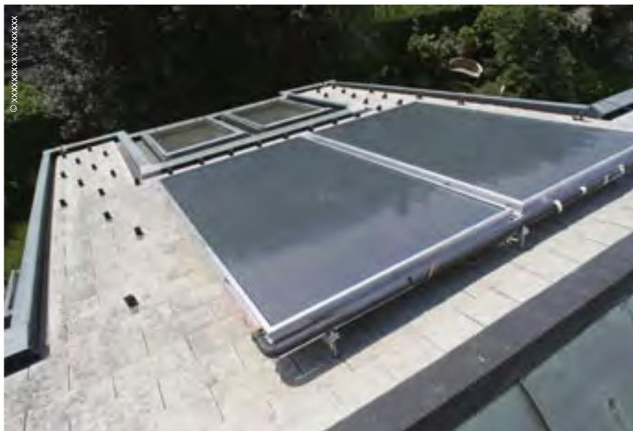
**Dämm- und Montagefehler:** niemals direkt Dachmaterial durchschrauben
