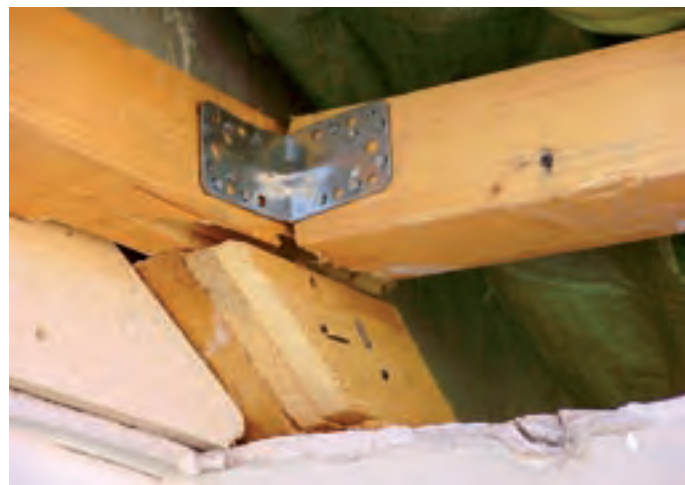
Zimmermeister Leckel von „PPL“ staunt und saniert die Sanierung der Sanierung, Winkelbelastung in die falsche Richtung und ...
