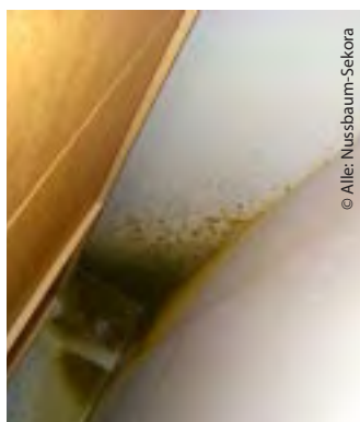
Garderobe mit Schimmelbefall, außen befindet sich der E-Schrank
