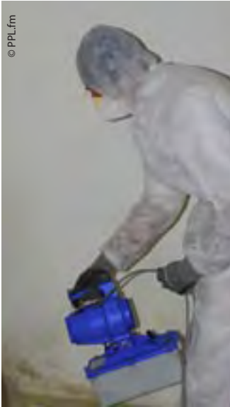
© PPL_fm Professionelle Schimmelentfernung bedingt eine Vernebelung mit Spezialmittel
