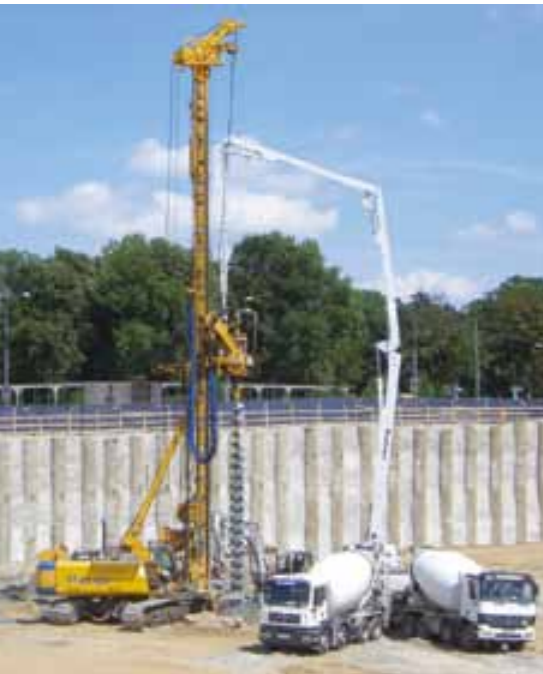
Ein Bauer BG40 Großdrehbohrgerät stellt für die neue Zentrale der Erste Bank in Wien Schneckentortbeton-Pfähle her, insgesamt waren 850 Stück SOB-Pfähle mit 65 cm Durchmesser und 20 m Tiefe nötig. Im Hintergrund fertige Pfahlwände.
