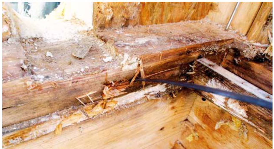
Passivhaus, n50-Luftwechselzahl 0,4/h1, dennoch Holzschaden durch Leckage an der Dampfbremse
