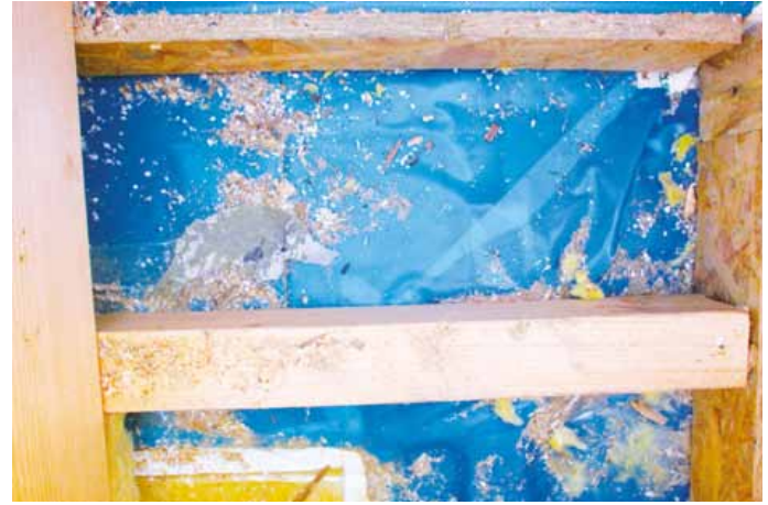
Passivhaus, n50-Luftwechselzahl 0,4/h1, dennoch Holzschaden durch Leckage an der Dampfbremse
