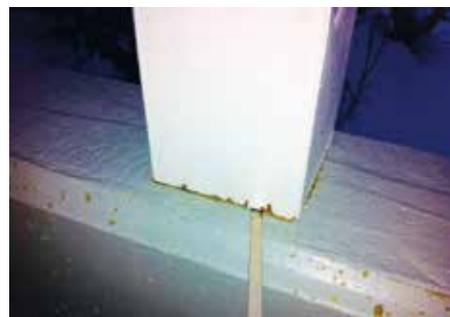
**Die unsachgemäß auf die Betonmauer gestellte Stuhlsäule ist bereits GK 4:** Holzschutzmaßnahmen sind zwingend.
