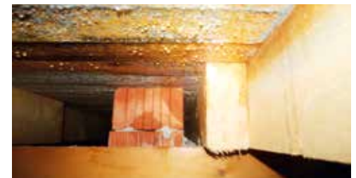
Heutiges Hochlochziegelmauerwerk ist nicht luftdicht, der Innenputz ist es.
