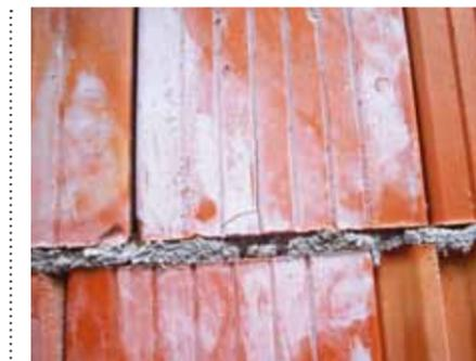
Mörtellagerfuge im Mauerwerk; einwirkender Frost hat die Druckfestigkeit auf ein Drittel herabgesetzt.
