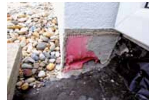
Das Stiefkind der Fassadenfirmen: Sockelabschlüsse auf Flachdächern, Terrassen. Im Bild erkennbar das WDVS ohne Trennung und Feuchteschutz zur Abdichtung.
