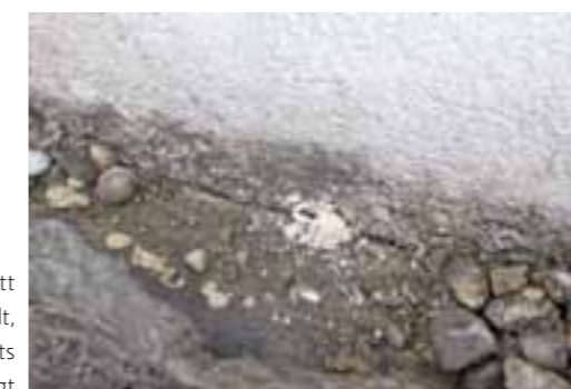
Das Stiefkind der Fassadenfirmen: Sockelabschlüsse auf Flachdächern, Terrassen. Im Bild erkennbar das WDVS ohne Trennung und Feuchteschutz zur Abdichtung.
