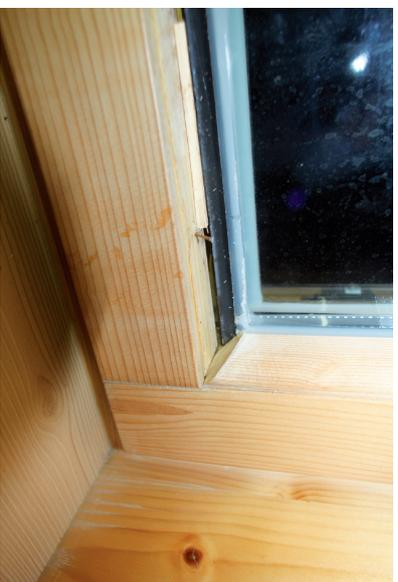
Wird der Falzraum von der Raumluft durchströmt, entsteht im Winter schädliches Kondensat.
